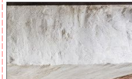
Facade RdC : béton blanc texturé effet "pierre brute"
